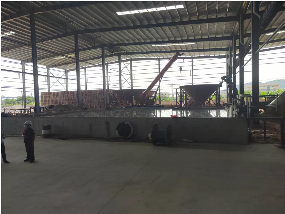
废水处理设施
